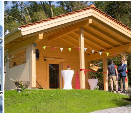
Naturkindergarten in Rohrdorf
